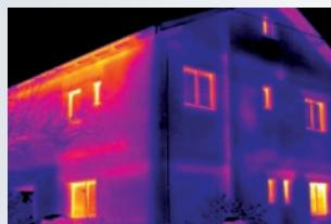
**Выявление энергетических потерь в зданиях:** Моментальное обнаружение и фиксация тепловых мостиков на фасадах или в ограждающих конструкциях знаний
