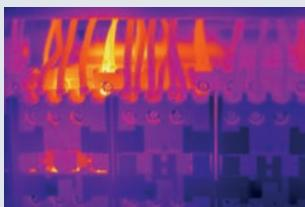
**Диагностика электрических систем:** Обнаружение аномально высокого нагрева автоматических выключателей и электрических компонентов до того, как произойдет поломка
